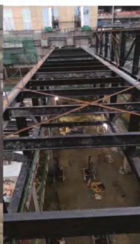
威尼斯人三期(巴黎人) 250噸桁架整體提升及滑移
